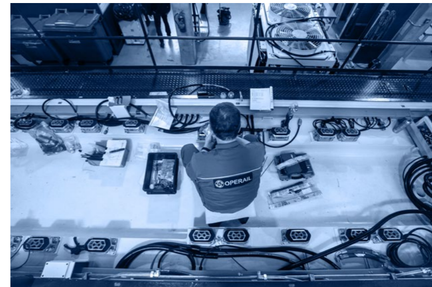
Veduri C30-M moderniseerimine Operaili Tapa depoo
